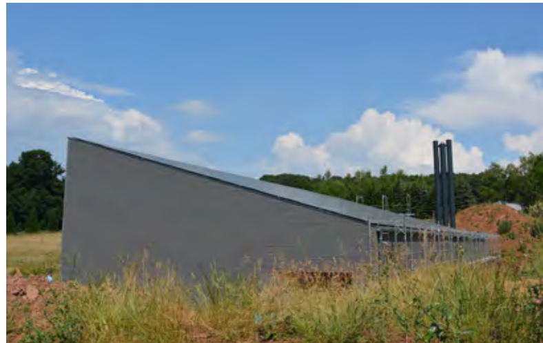
Die neue Heizzentrale im südöstlichen Teil des Geländes am Bildungsstandort Hardehausen
