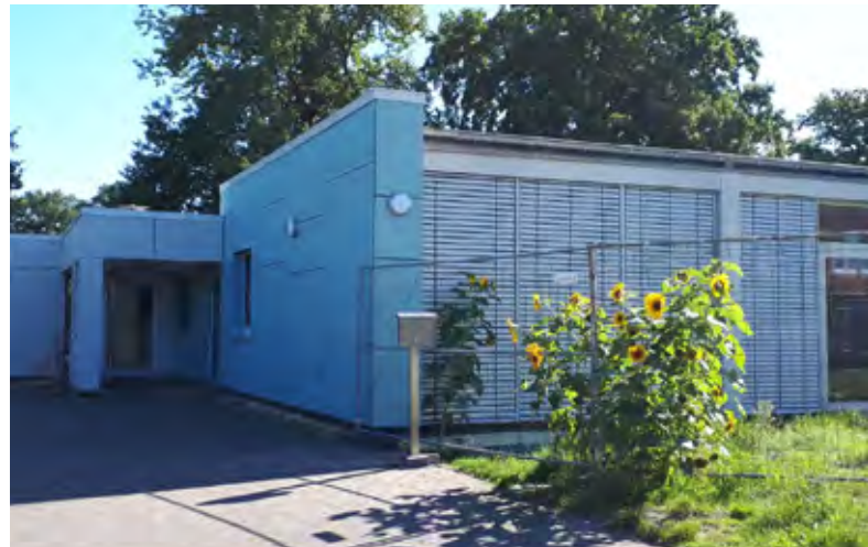
Der sanierte und wärmedämmte Eingangsbereich der Kita St. Joseph in Paderborn-Mastbruch
