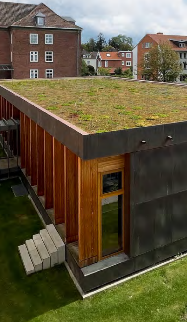
Das 2019 angelegte Gründach auf dem Audimax der Katholischen Hochschule NRW (katho) am Standort Paderborn bietet verschiedene nachhaltige Vorteile: von der Biodiversität bis hin zu einer verbesserten Energieeffizienz.
